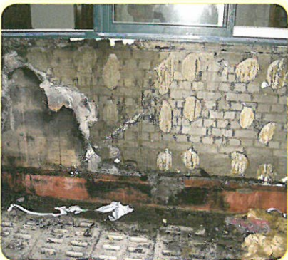
○○초등학교 건물 외벽
